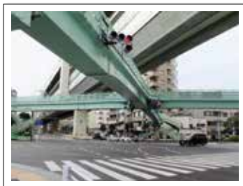
溝田橋交差点で明治通りは写真手前から左側へ曲がる。歩道橋の形が下から見るとXの形をしていて、ユニークで面白い。
