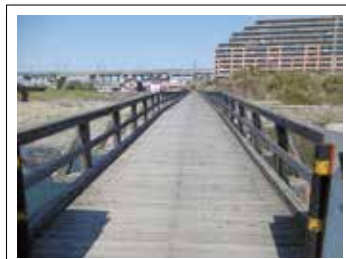
かつてここに舟橋があったとされる現在の佐野橋
