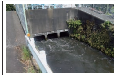
深良用水 下郷地域を灌漑している大堰
